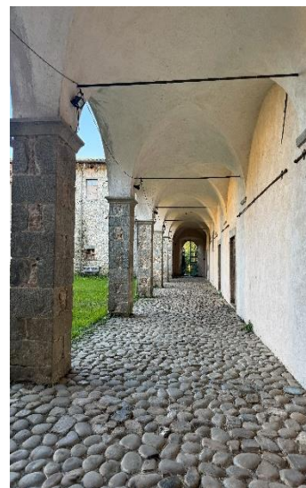
Figura 27 Pavimentazione in ciottoli
