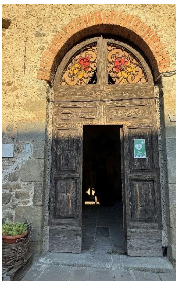
Figura 26 ingresso Servizi igienici non attrezzati
